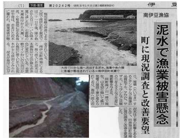
南伊豆工事現場と伊豆新聞
