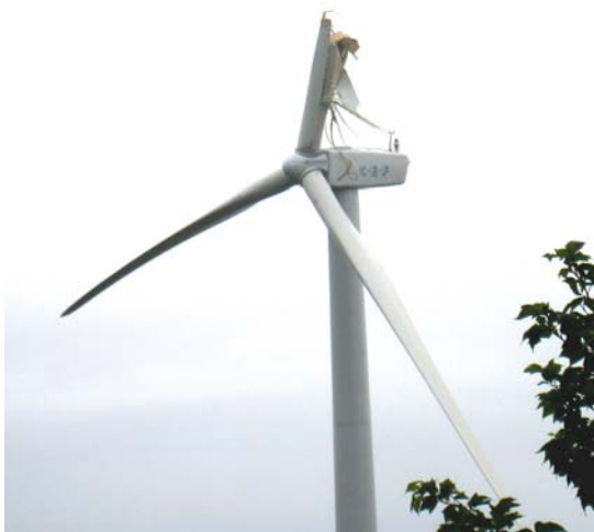
写真は今年5月28日にブレードが破損、落下したCEF伊豆熱川8号機
