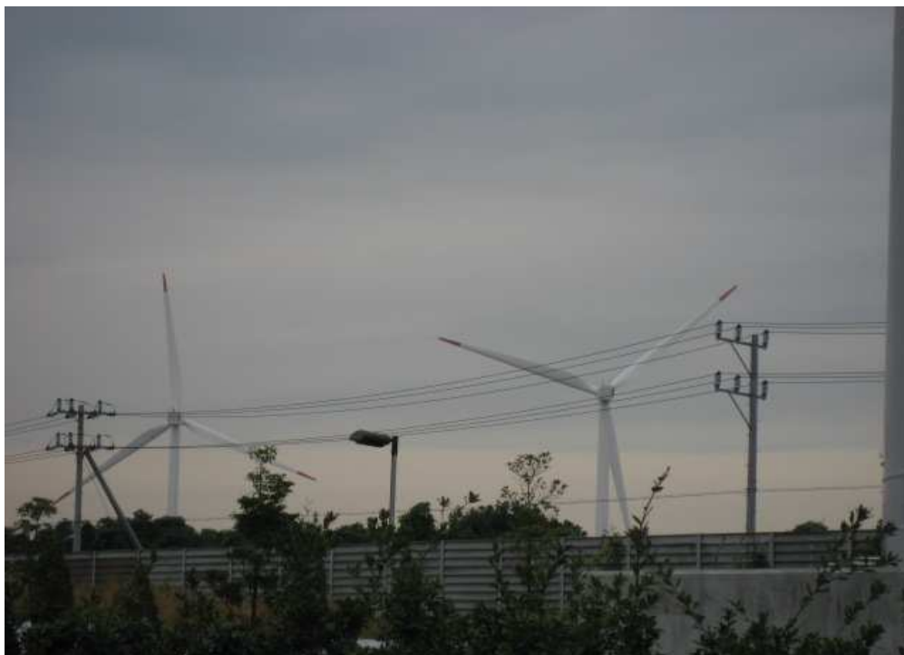
田原臨海風力発電所
