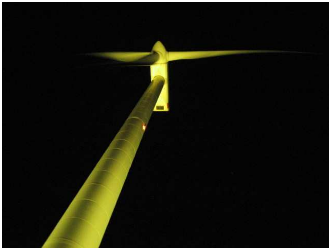
田原臨海エコパーク内の風車 ベスタス 2000kw
