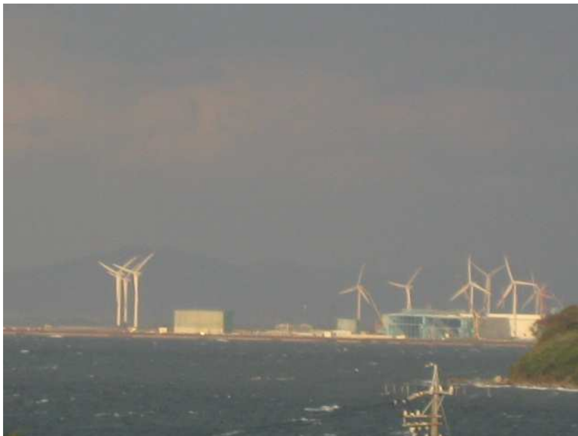
R259 から田原臨海風力発電所を望む (ベスタス 1980kw,2000 kw)
