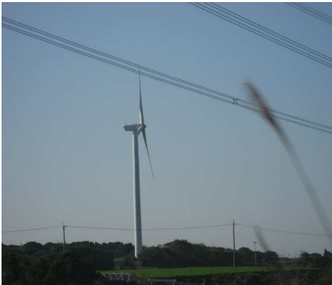
〇さん宅近くより久美原風力発電所を望む
